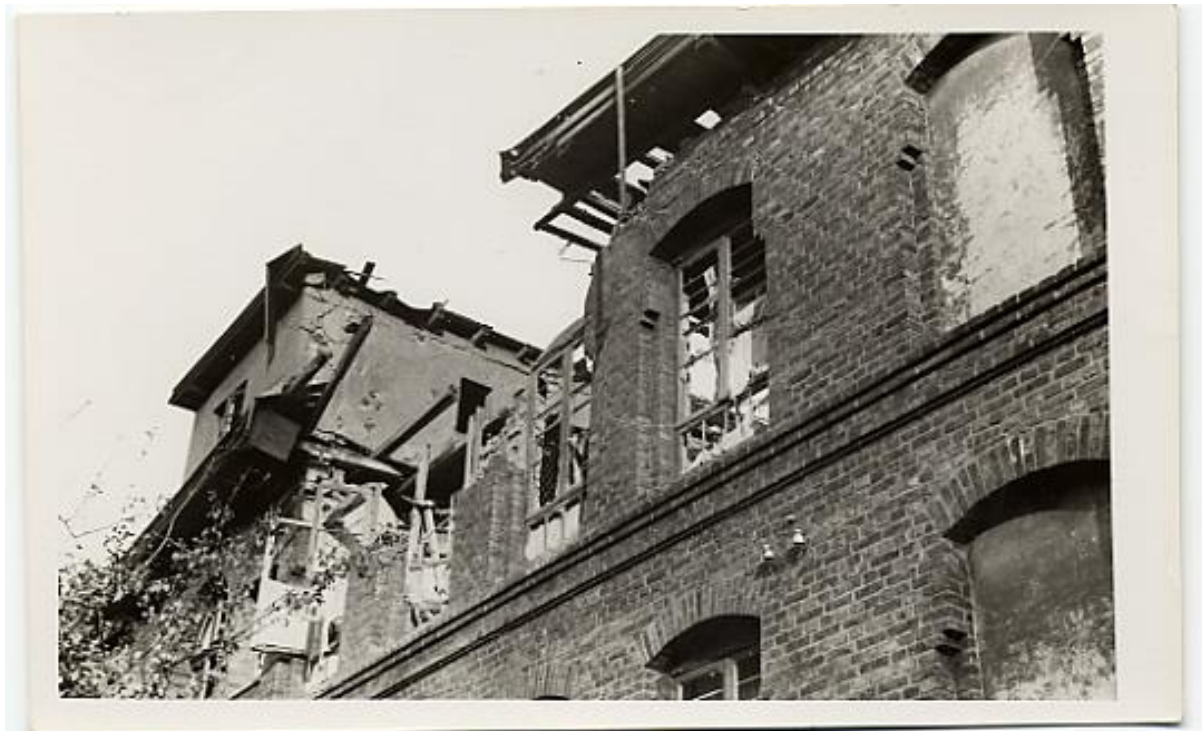
Blick von unten auf eine zerstörte Etage des Pflegehauses Klein-Bethel. (HAB F 1015)
