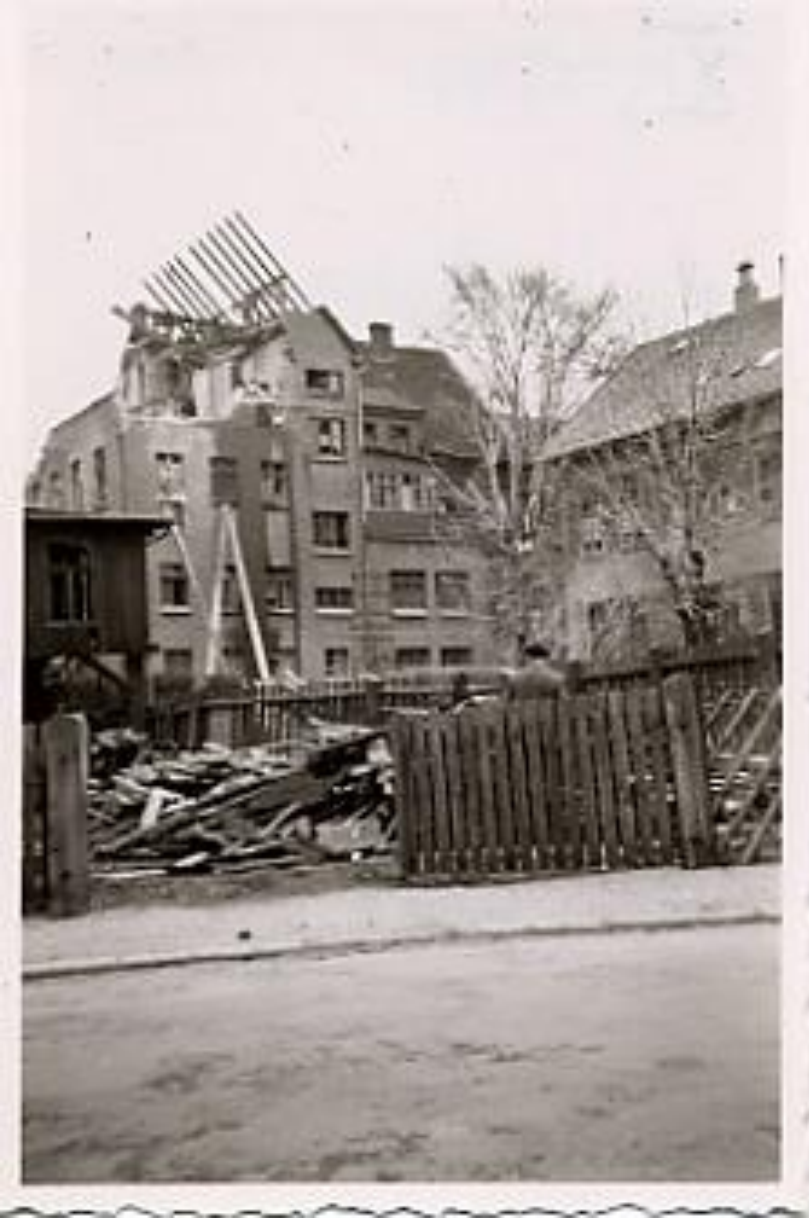
Blick auf das zerstörte Gebäude Horeb
