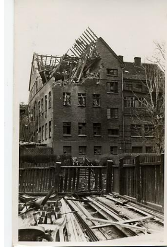
Ein Blick auf die Westseite des zerstörten Pflegehauses Horeb. (HAB F, 1244)
