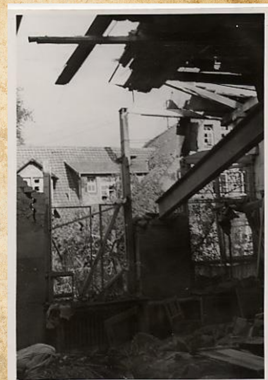
Blick aus einem zertrümmerten Schlafsaal auf das Haus Siloah.
