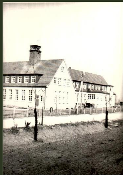
Waschhaus und Speisesaal (HAB F, 1410)
