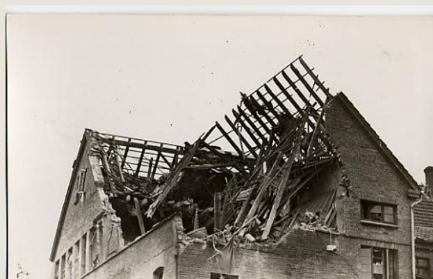
Luftangriff auf Bethel (Horeb; Schuhmacherei) 31.03.1941 Blick auf die Westseite des von zwei Fliegerbomben getroffenen Pflegehauses; das Dach ist eingestürzt; in dem darunter liegenden Zimmern liegen Trümmer; Fensterscheiben sind zerbrochen (HAB F, 1245)
